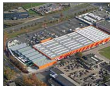
2500 m 2 lichtoppervlak snel en efficiënt geplaatst
